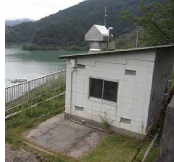
小河内ダム集水域内に設置されているヨウ化銀発煙所
